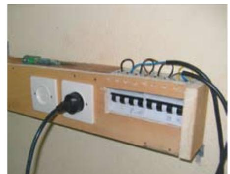
...und für den Bau des Kabelkanals verwendet. Das Endstück eines 6m langen Kabelkanals.
